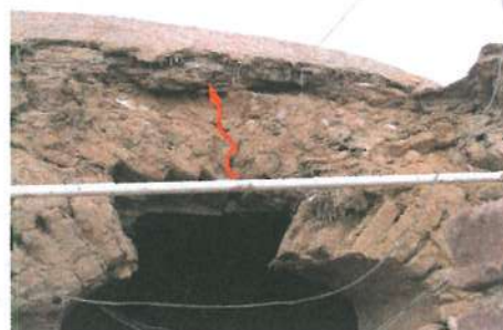
شکل ۲۲: گسترش ترک به سمت سقف
