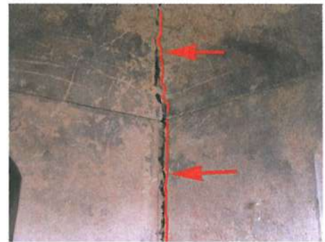
شکل ۲۳: جدا شدن دیوارها در محل کنج
