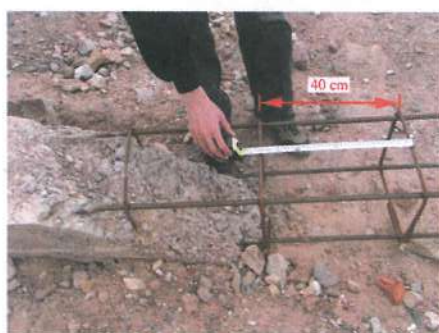
شکل ۱۶: فاصله بین خاموت‌ها بالغ بر ۴۰ سانتیمتر است
