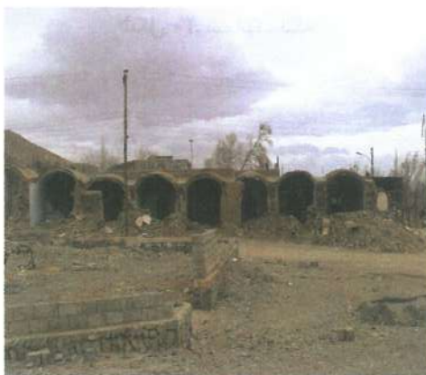
شکل ۲۷: حفظ پایداری سقف‌ها در اتاقهای مجاور
