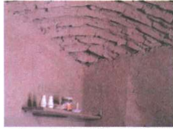
(ب) سقف قوسی چهار ترک
