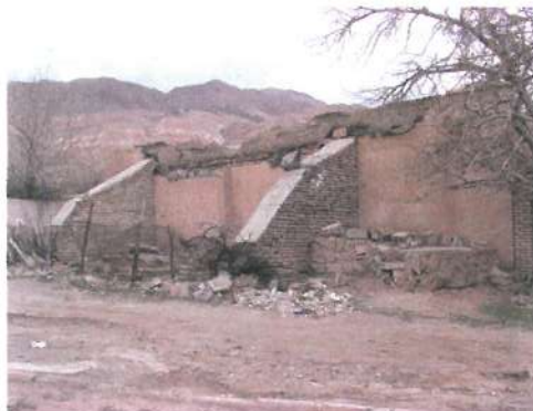
شکل ۲۹: استفاده از دیوارهای حایل برای حفظ تعادل جانبی دیوارها
