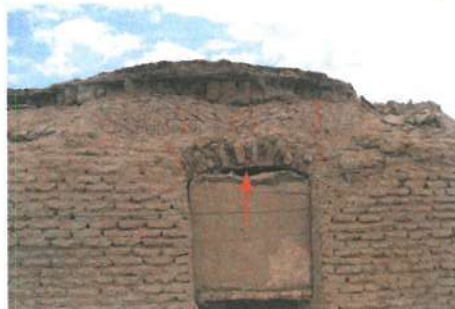
شکل ۲۱: گسترش ترک به سمت سقف
