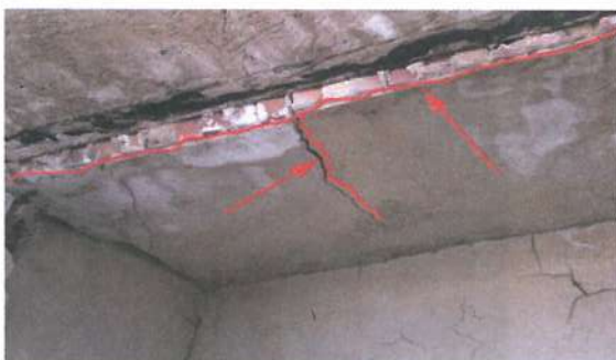
شکل ۱۳: خارج شدن سقف‌های طاق ضربی از محل تکیه‌گاه
