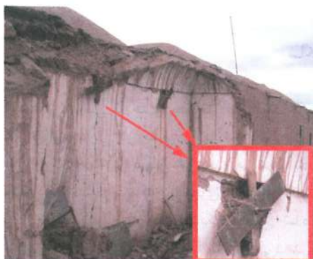
شکل ۲۸: استفاده از میل مهار برای مهار دیوارهای مقابل
