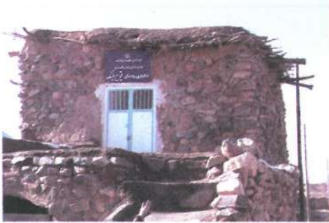
(ج) دیوارهای سنگی با سقف مسطح
