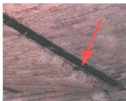
شکل ۱۳: خارج شدن سقف‌های طاق ضربی از محل تکیه‌گاه
