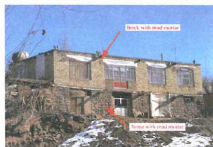
شکل ۱۹: آجر به همراه ملات گل و تیرهای آهنی به جای تیر چوبی به کار رفته‌اند
