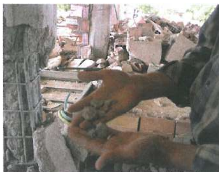
شکل ۱۸: بتن به راحتی با دست خرد می‌شود
