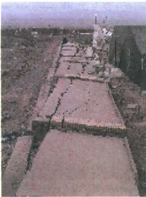
شکل ۱۲: مقاومت کم دیوارها در مقابل نیروهای خارج از صفحه
